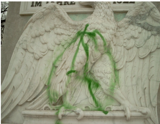
Sprühdosen-Graffiti auf einer Marmoroberfläche, die zuvor prophylaktisch mit einer temporären Schutzschicht auf Polysaccharid-Basis behandelt wurde.
