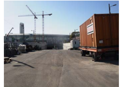
Tunnelmund der B 96 im Bau
