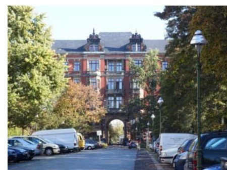
Blick aus der Kruppstraße zur Lehrter Straße
