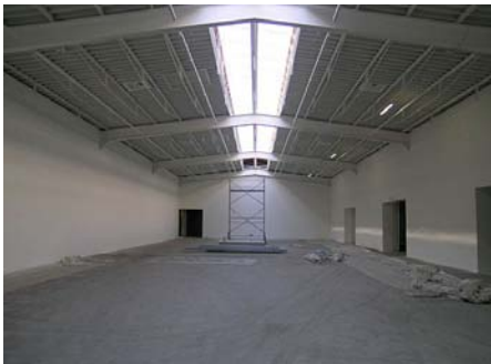
Rieck-Halle im Umbau
