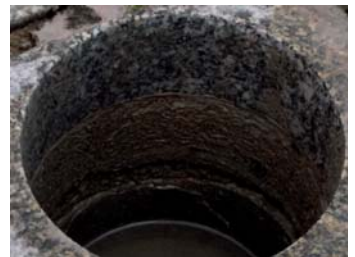
1.5 Bohrloch zeigt abgesicherten Schichtenverbund
