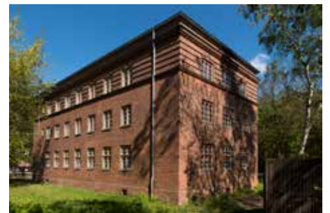
Haus Tabea | © Erik-Jan Ouwerkerk
