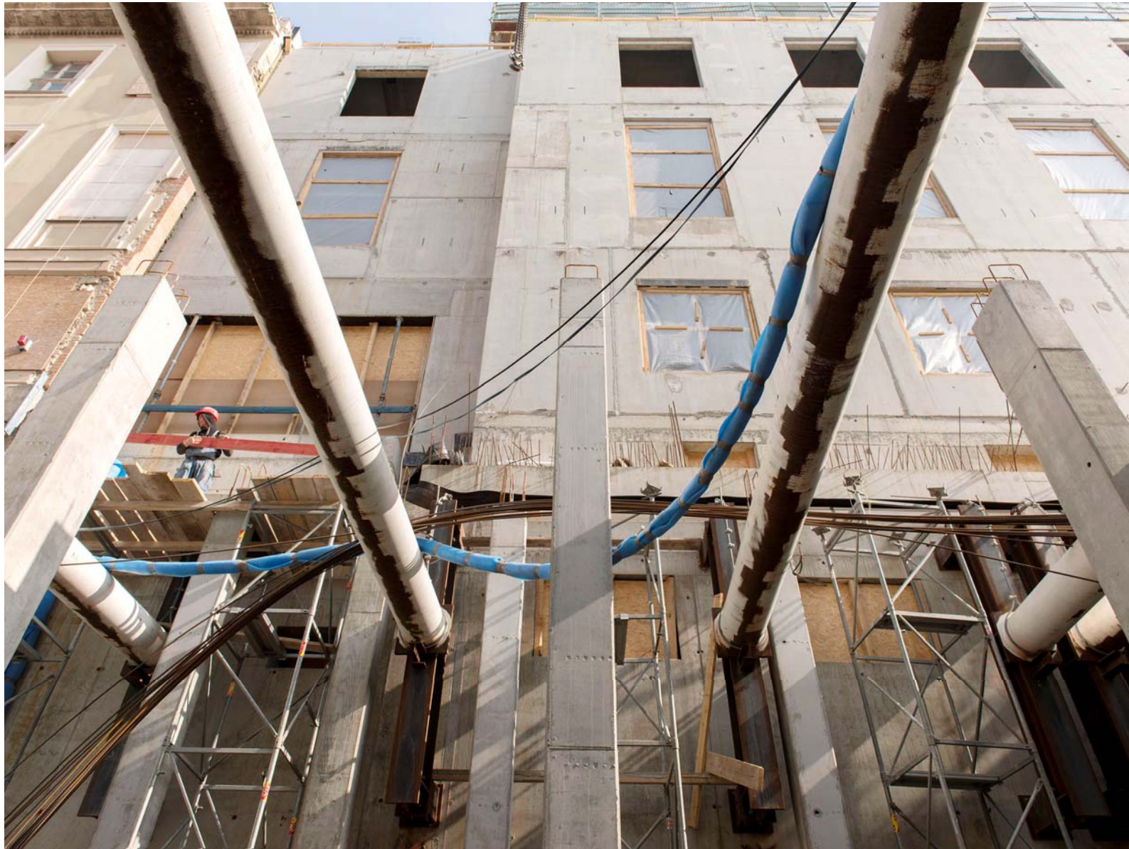
Das neue Probenzentrum mit der Baugrube für das unterirdische Technikgebäude
