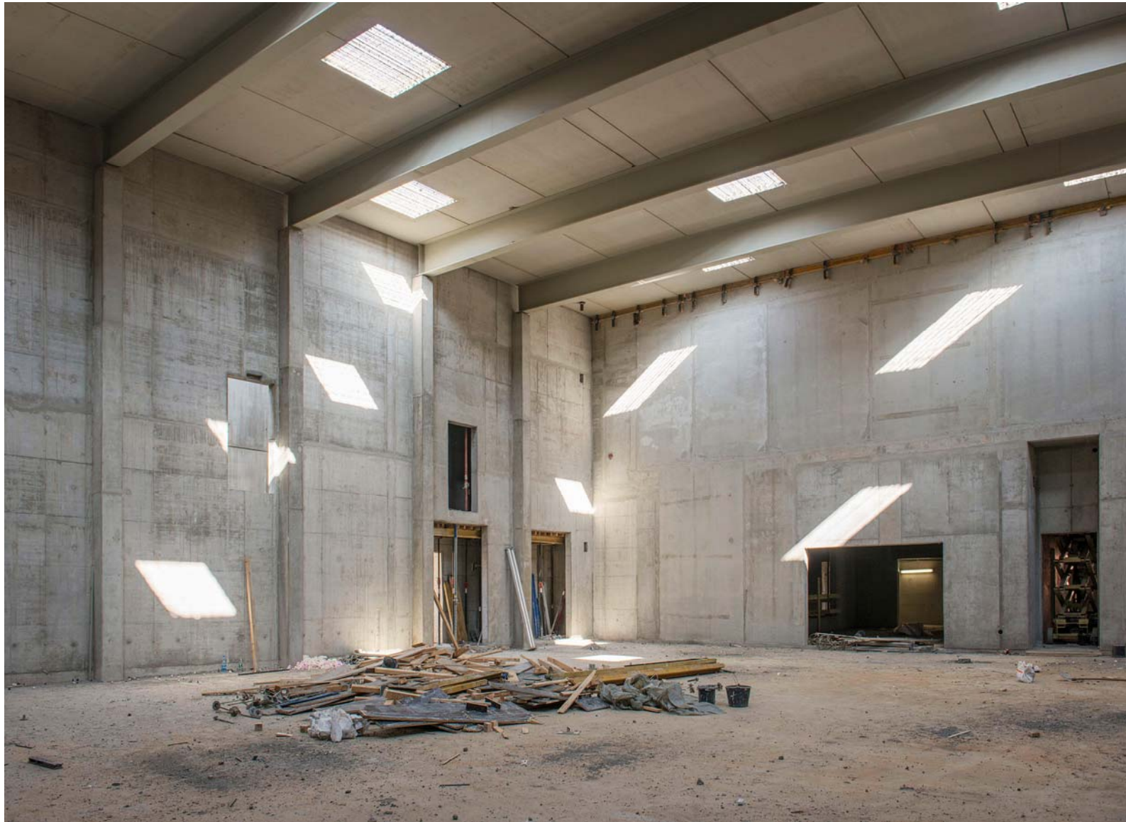
Neuer Probensaal im Rohbau fertiggestellt
